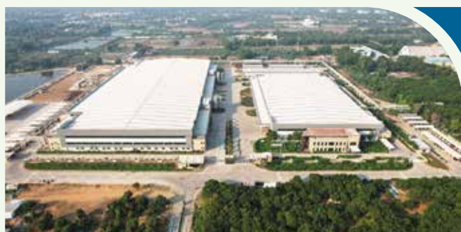
कलोल नैनो प्लांट / Kalol Nano Plant
