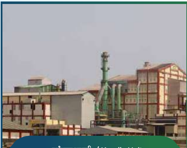
कांडला इकाई / Kandla Unit
